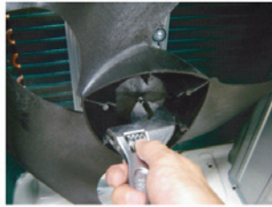
Remove the FAN Nut.
